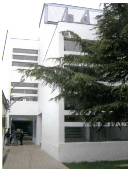
Edificio, costado oriente.
